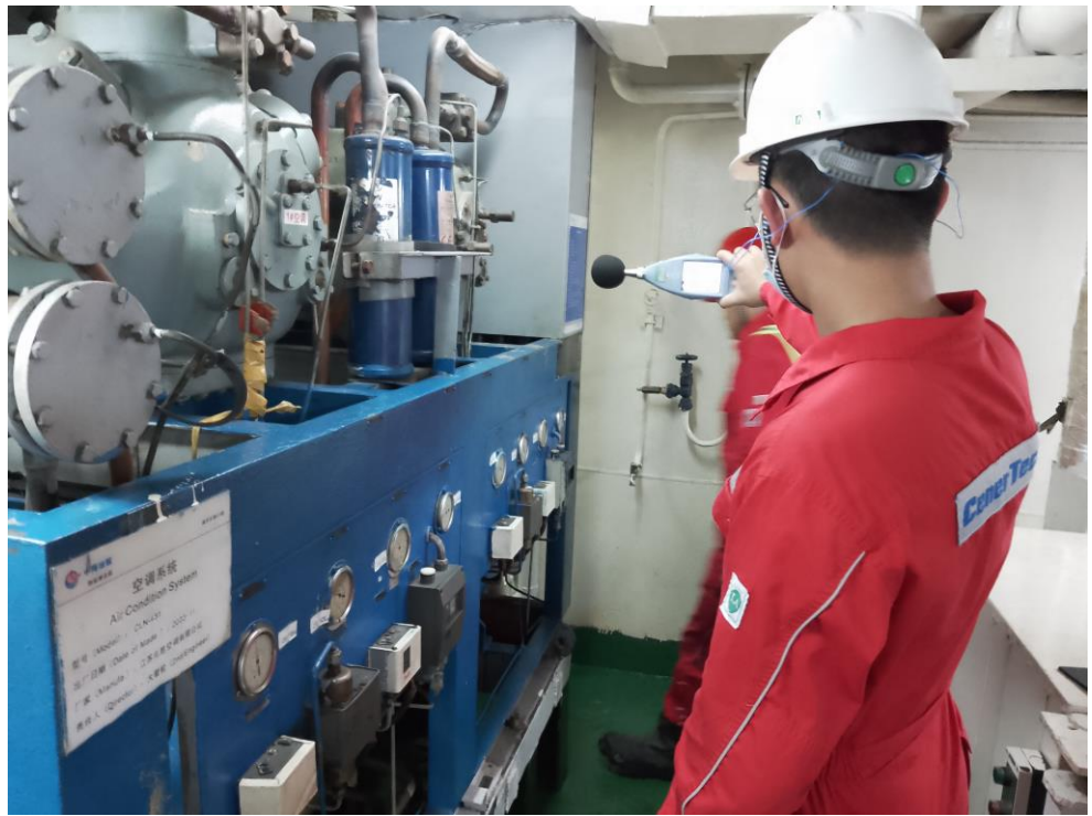
现场测量相片
