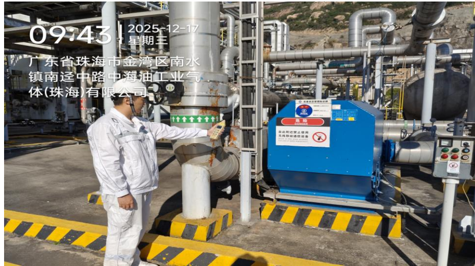
现场测量照片
